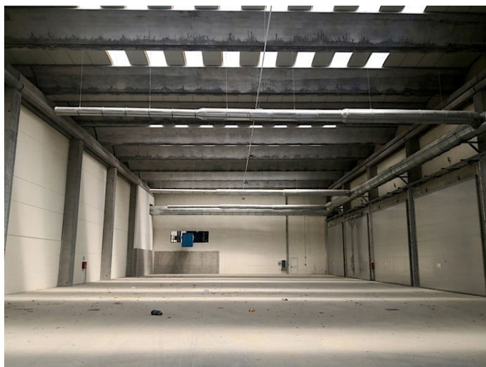
Figura 5 Vasche di insufflaggio del nuovo impianto di biostabilizzazione dei rifiuti.
