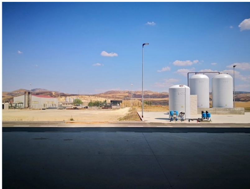
Figura 7: a destra, vasche per il contenimento del percolato; a sinistra, impianto per il riutilizzo del biogas.
