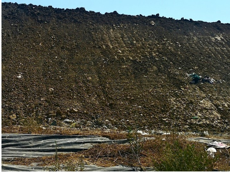
Figura 8: La MISOP effettuata per scongiurare la compromissione ambientale a seguito di fuoriuscita di percolato da una delle vasche di abbancamento.
