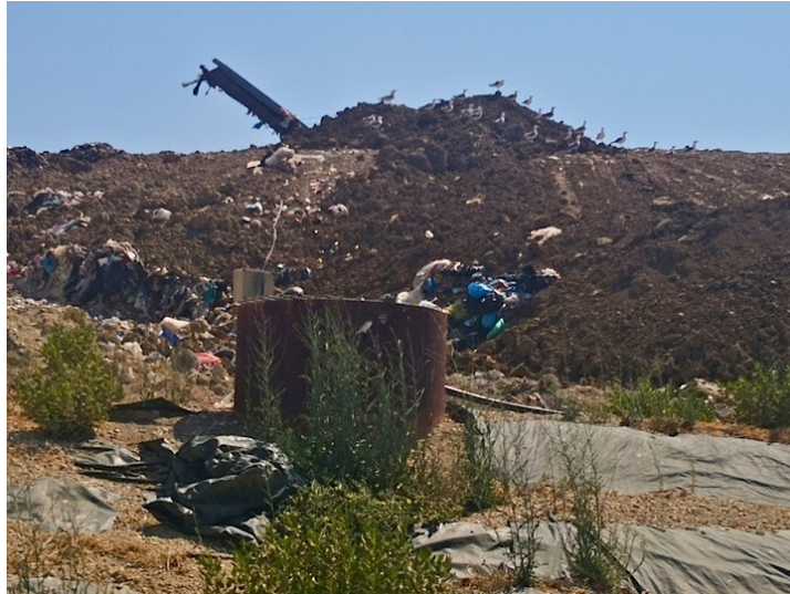
Figura 6: Pozzetto - spia per il monitoraggio del livello di percolato.
