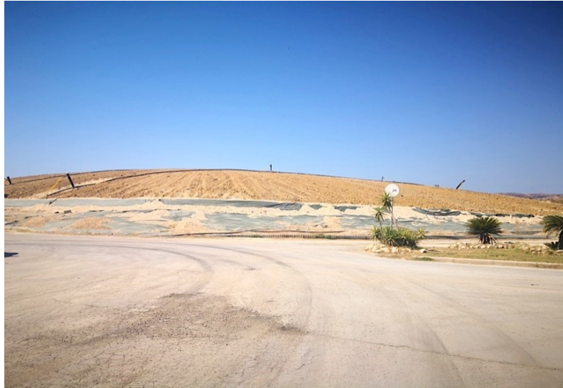
Figura 1 Il cd. panettone, ossia una vasca che, esaurita la propria capacità di abbancamento, è stata ricoperta con materiali impermeabilizzati e successiva posa di terra da riporto, in attesa di ulteriori interventi. In particolare, in un'ottica di ripristino ambientale, verranno piantati arbusti e piante in grado di ricreare la vegetazione sul terreno.
